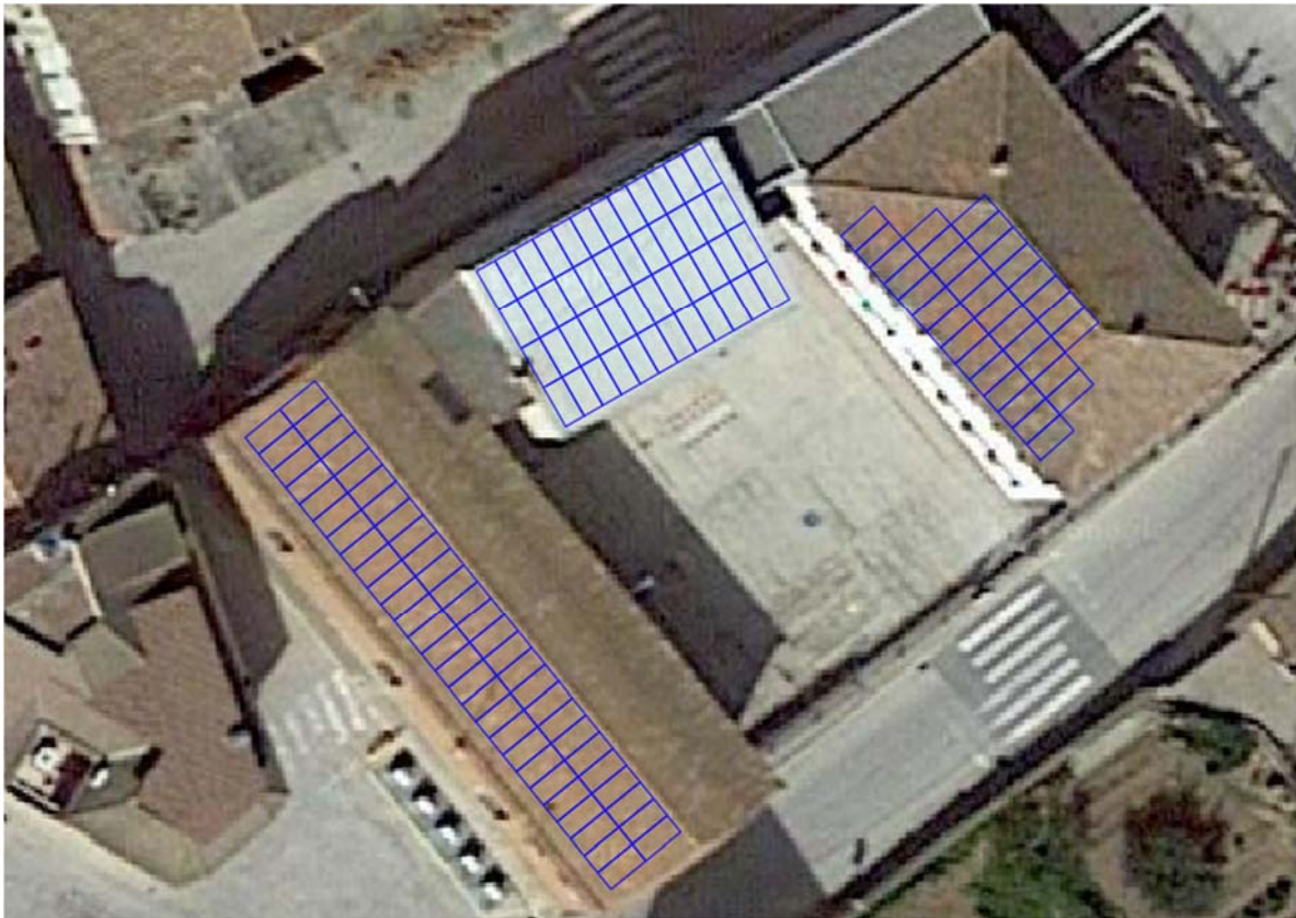
Figura 4. Imagen del edificio actual e integración de los módulos.
